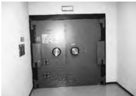
中間保管庫扉
