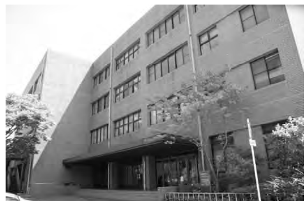
大阪大学アーカイブズの置かれている管理棟
