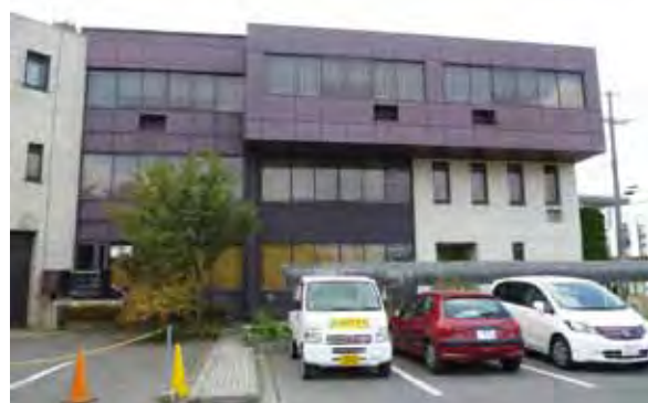
公文書館外観(建物3階部分)
