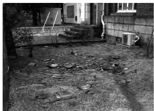
写真1 落下した屋根瓦
