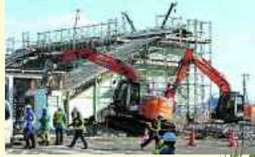
駅舎等の解体
